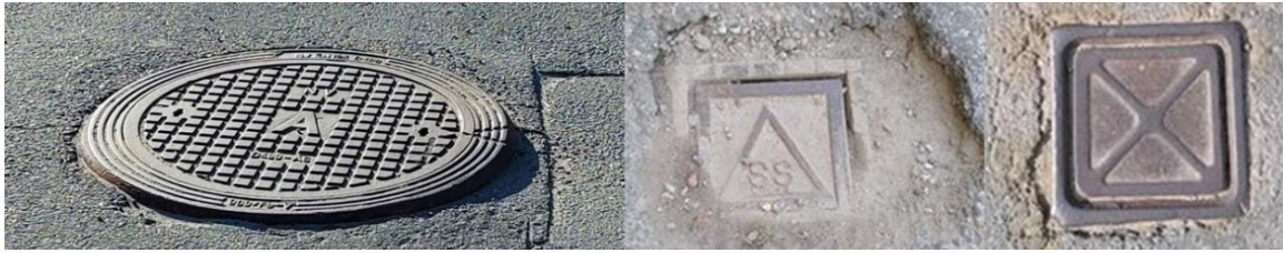
Figur 13. Urval av olika typer av brunnar med större sättningar
