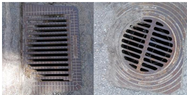
Figur 8. Ett urval av dagvattenbrunnar
