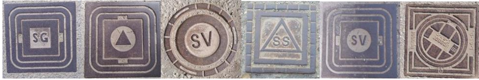
Figur 6. Ett urval av olika typer av ventiler. Från vänster: servisventil till fastighet (gas), Polygonpunkt, Servisventil till fastighet (vatten), polygonpunkt, Servisventil till fastighet (vatten), spolbrunn. Brunnarna är ofta kvadratiska med sidan 20 cm, det förekommer även cirkulära med diametern 20 cm.
