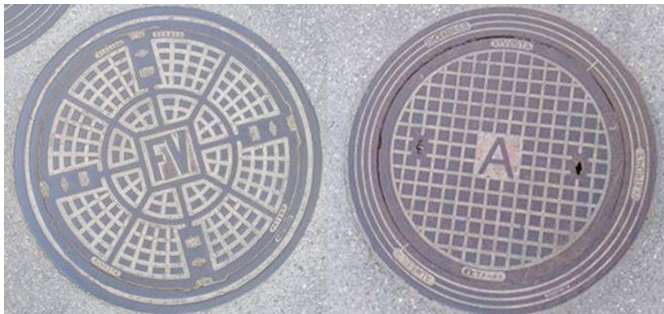
Figur 7. Ett urval av olika manhålsbrunnar, till vänster en för fjärrvärme och till höger en avloppsbrunn. (Diameter 80 cm)
